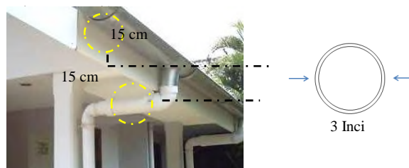
Gambar 2. Dimensi talang dan pipa distribusi
